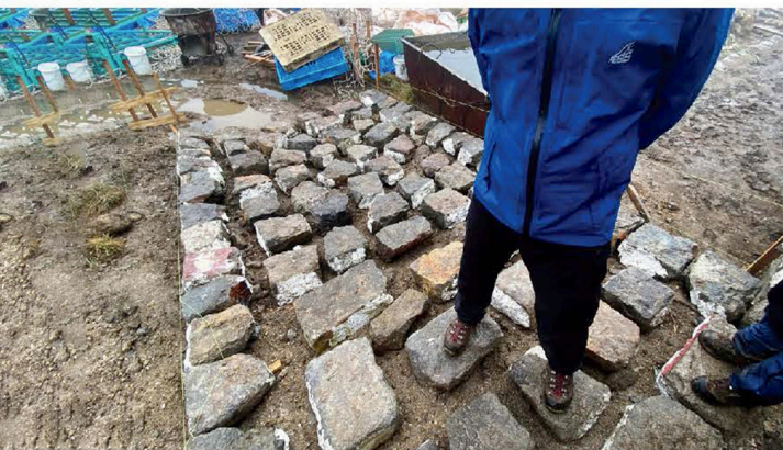
▲避難小屋編スロープには、旧避難小屋の壁石が敷きつめられる
