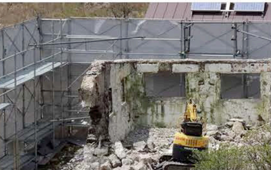
▲解体した旧避難小屋。重機をヘリで運んでの作業
